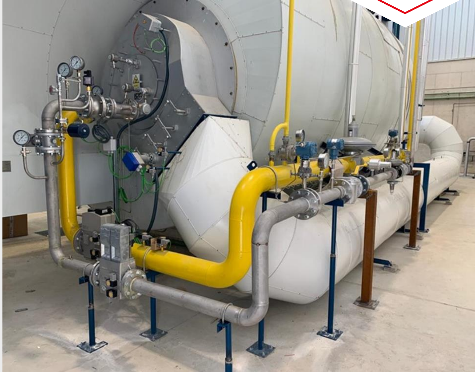
图 6: RAY-EGELHOF公司从氢气中获得的工艺热能 具有最低的氮氧化物排放 (图片地点：西班牙卡塞达)
