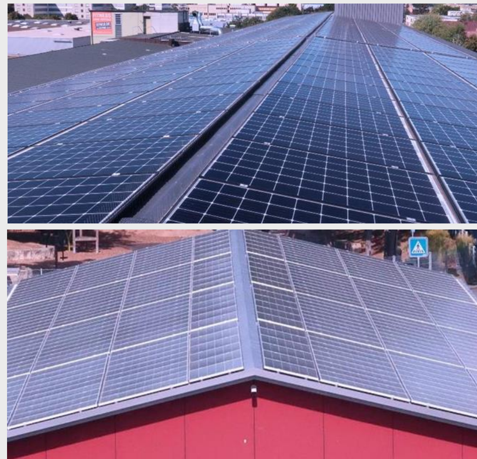
图 10: Fellbach总部主楼和仓库的屋顶区域
