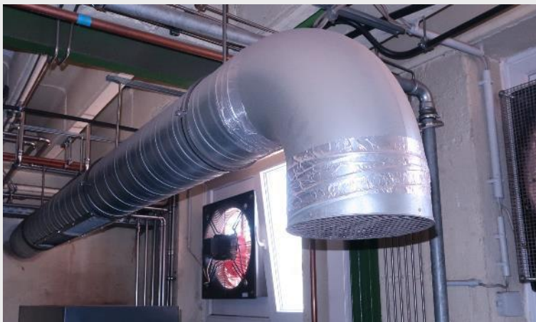
图 11：压缩机舱内暖空气的进气接口
